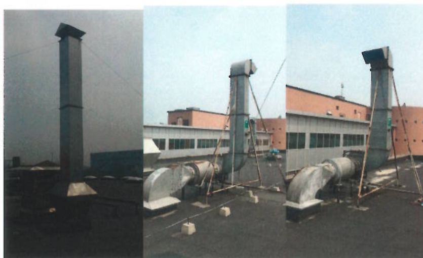
印刷废气排口+PPW 制版和装版室内无组织排放废气+PPE 油墨间和清洗间
